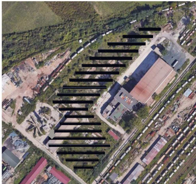
Fig. Zona 2 Panouri fotovoltaice
