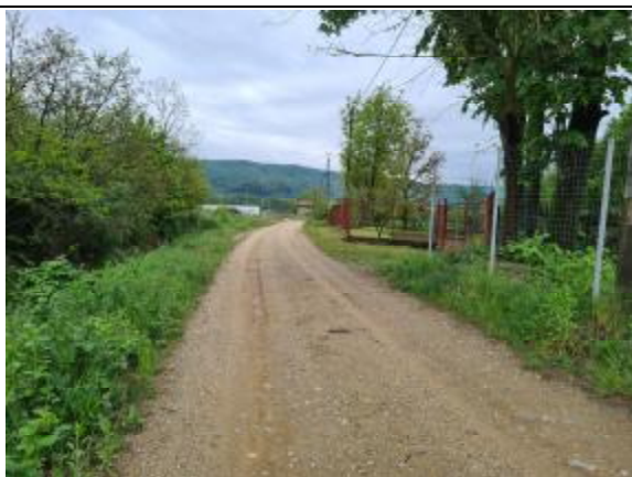
03. Strada Valea Balceasca
