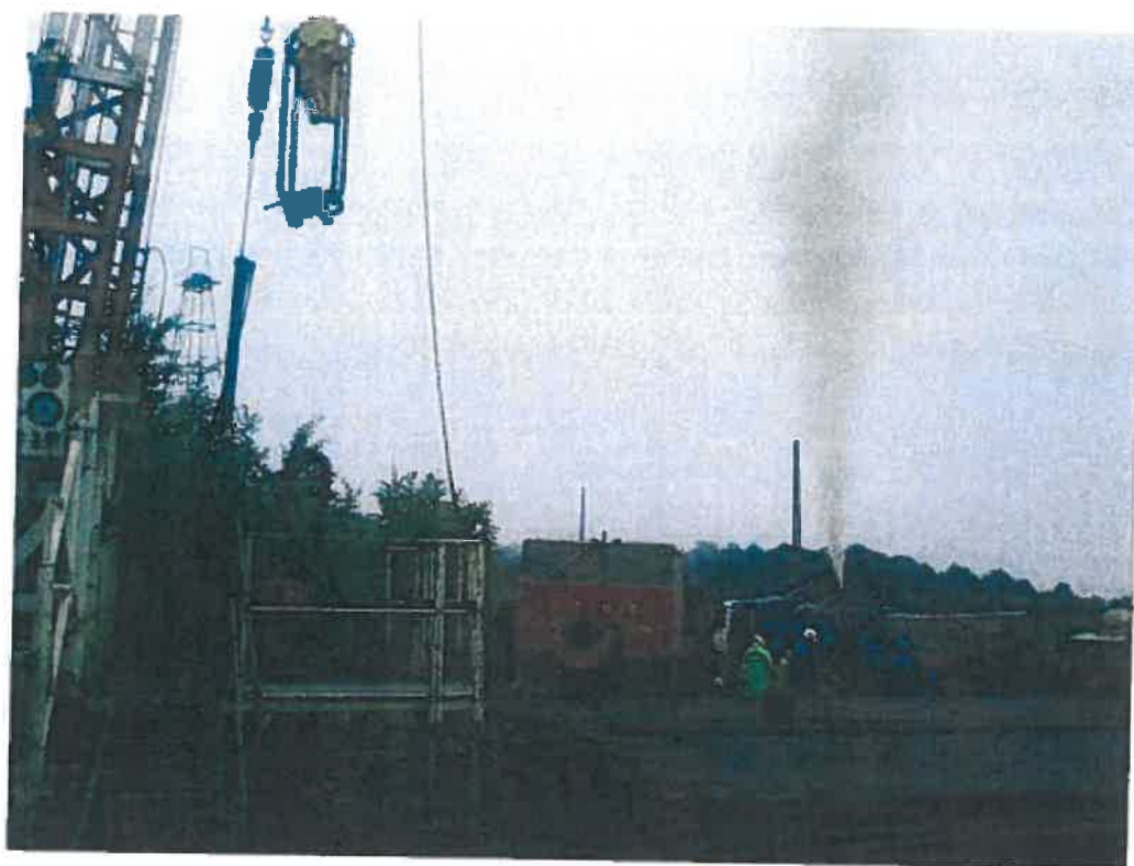
Operatia de cimentare dop in coloana de 5 3/4"cu oglinda la 1547m
