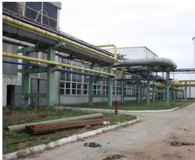
Amplasament conducte pe Estacada existenta
